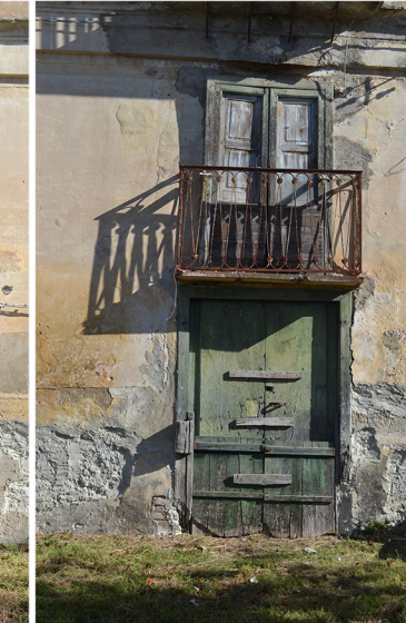
[2] alterazione cromatica ossidazione delle ringhiere degrado avanzato degli infissi
