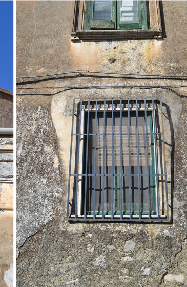
[6] patina biologica impianti a vista fessurazione delle decorazioni
