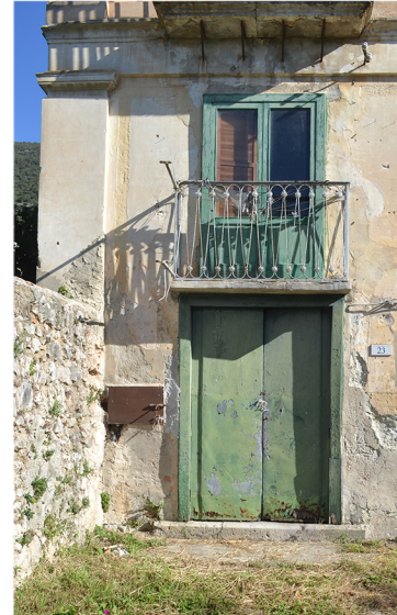
[1] alterazione cromatica impianti a vista degrado avanzato degli infissi
