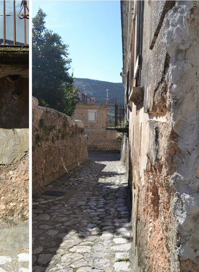
[8] utilizzo di intonaci cementizi mancanza di lesena distacco dell'intonaco
