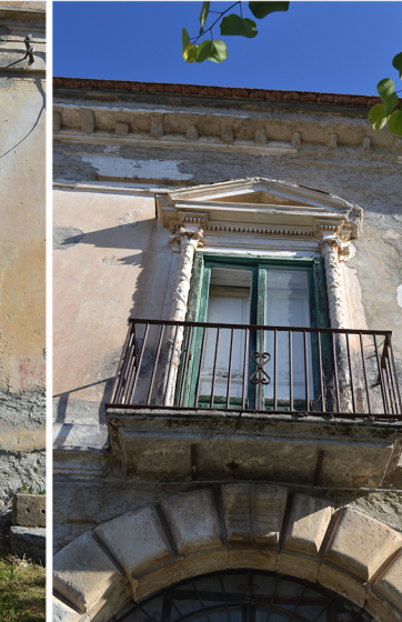
[3] distacco dell'intonaco ossidazione delle cornici ossidazione delle ringhiere
