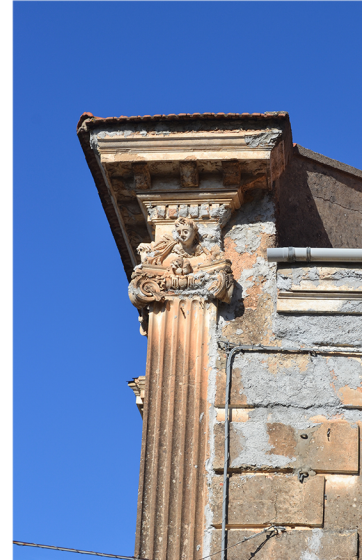
[5] alterazione cromatica impianti a vista utilizzo di intonaci cementizi
