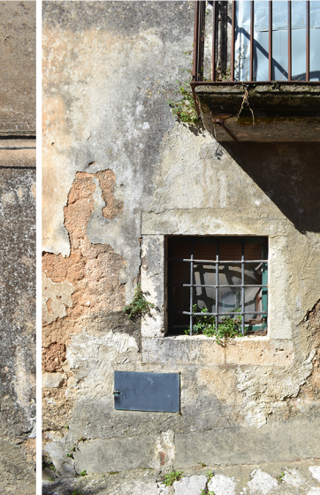
[7] patina biologica presenza di vegetazione distacco dell'intonaco
