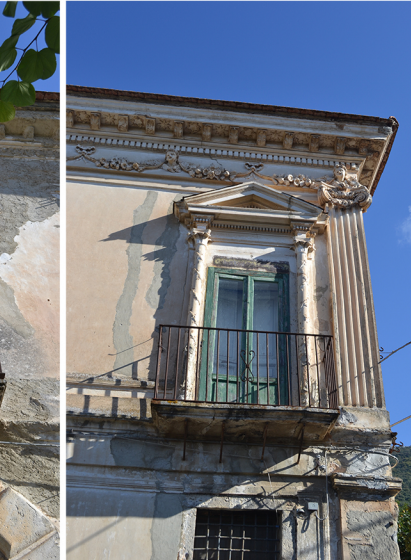
[4] macchie da dilavamento patina biologica fessurazione delle decorazioni
